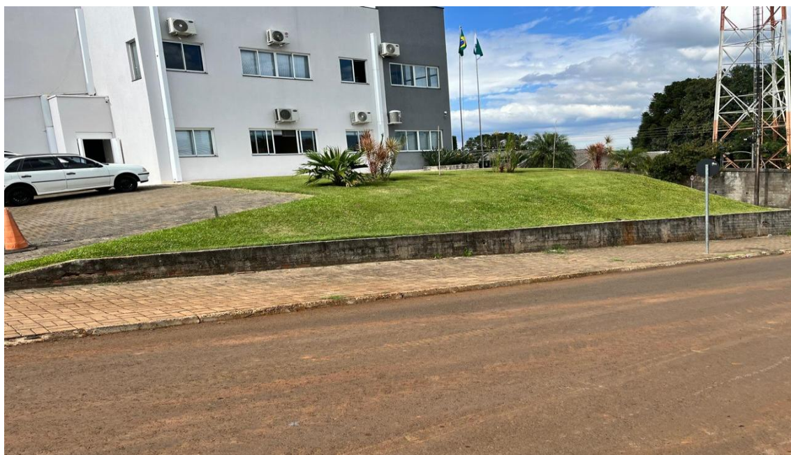
MURO 25,00 M X 0,50 A 1,20 M
